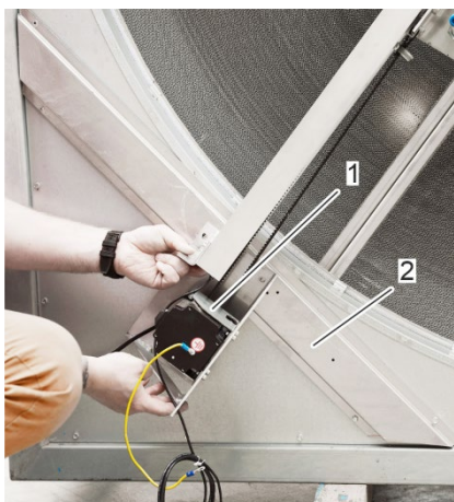
Figura 34: Alineación del extremo del riel de limpieza del lado del motor
