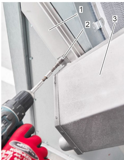
Figura 53: Montaje de la bandeja de recogida
